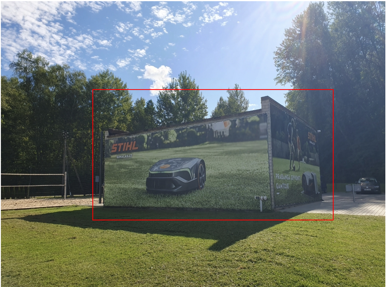
Fotonuotrauka Nr. 2 Remontuojamas statinys – Siurblinės pastatas (unikalus Nr. 4400-5542-8070), Šilo g. 2, Kazlų I k., Kazlų Rūdos sen., Kazlų Rūdos sav., pažymėtas raudonu kontūru. Vaizdas iš šiaurės vakarinės sklypo pusės.
